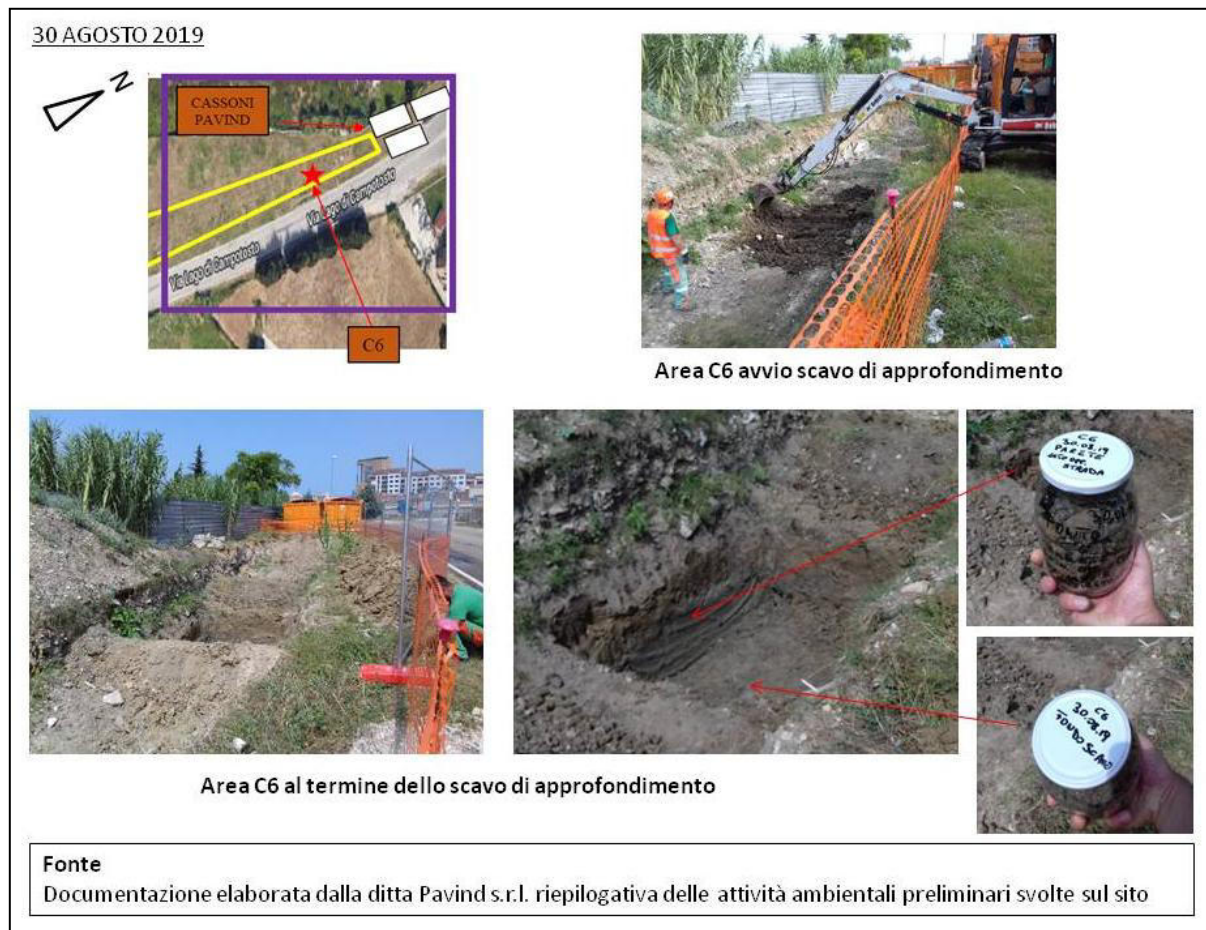
Figura 14: scavo di approfondimento in area C6 (30 agosto 2019)
