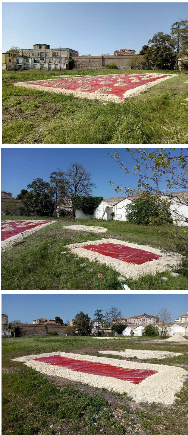
Fig. 6: Foto intervento di copertura mediante teli in LDPE
