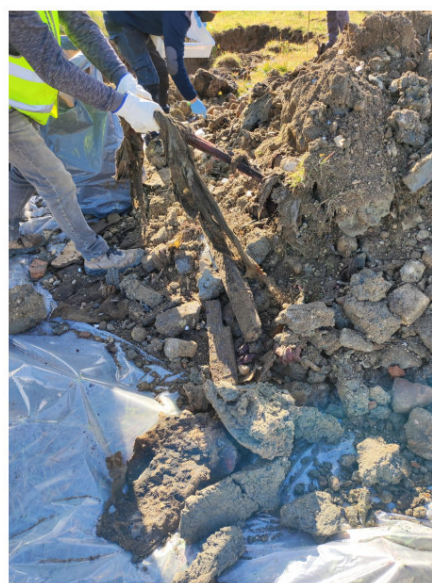
Foto 7 - Trincea TR7 fasi di campionamento del rifiuto.
