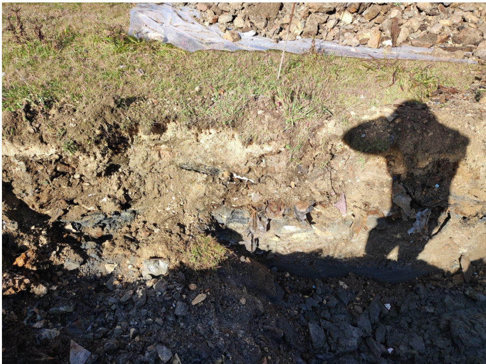
Foto 1 - Trincea TRS13 – fasi di realizzazione dello scavo con rinvenimento dell'orizzonte di riutto.
