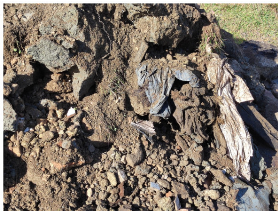
Foto 4 - Trincea TRS13 dettaglio dei rifiuti estratti.
