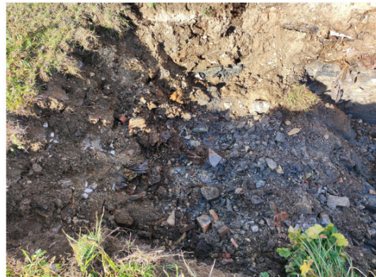
Foto 2 - Trincea TRS13 – dettaglio.
