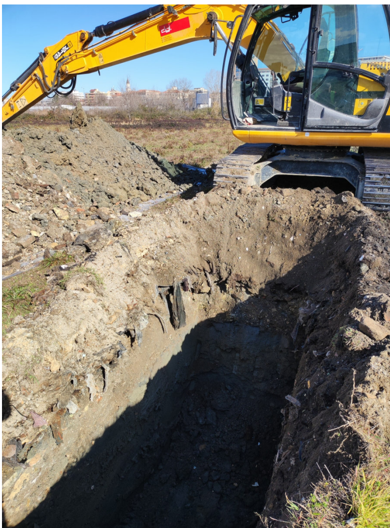
Foto 8 - Trincea TR7 – dettaglio scavo e orizzonte di rifiuto.
